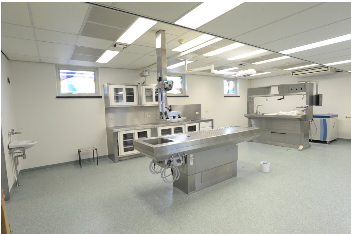
Obductiekamer na renovatie
